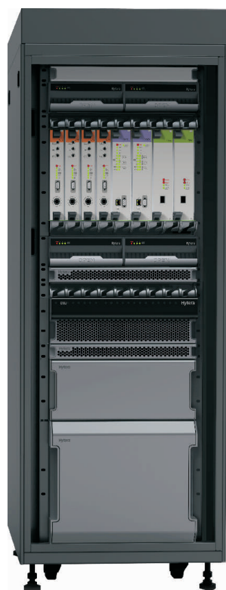
Przykładowy system trunkingowy DMR
